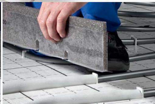
Breiter Klebefuß und seitliche Kunststoffverstärkung für senkrechten, stabilen Stand und geradlinigen Verlauf.
