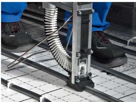
Der schmale, abgerundete Auflagefuß des xnet Tackergerätes ermöglicht das einfache und sichere Setzen der Rohranker auf der Tackerdämmung.
