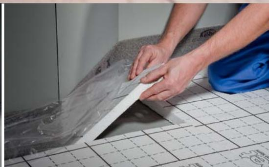
xnet C12 Tackerfaltplatte in verschiedenen Dämmdicken mit handlichen 2 m<sup>2</sup> pro Platte. Perfekt für kleine Räume.
