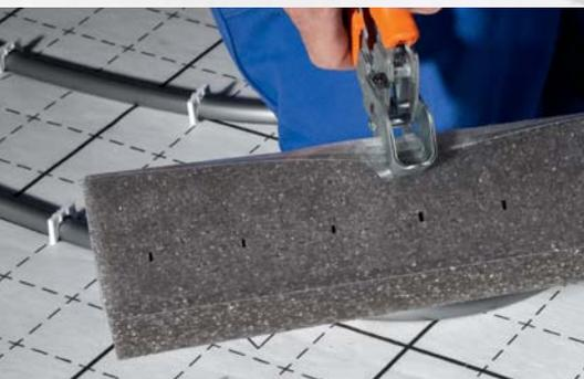
Ausschnitt der Rohrdurchgänge mit xnet Ausklinkzange. Einfache Ausschnitt-Positionierung durch aufgedruckte Rastermarkierung im Rastermaß der xnet C12 Tackerdämmung.
